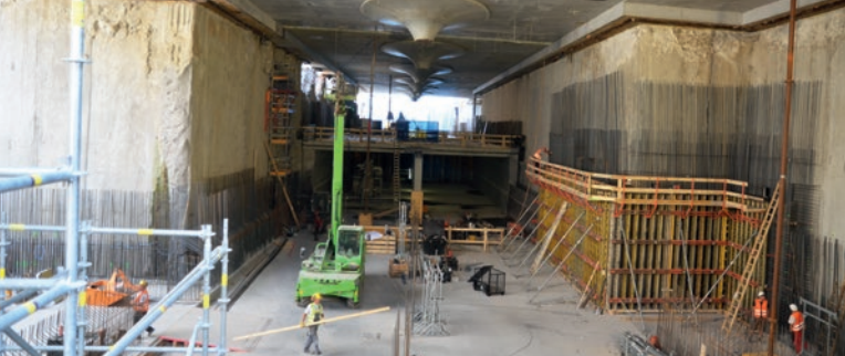
Blick in den Rohbau des U-Bahnhofs Berliner Rathaus in Richtung Alexanderplatz
