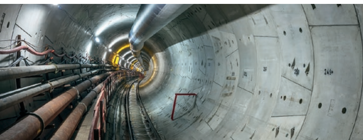
Einblick in die zweite neue U5-Tunnelröhre
